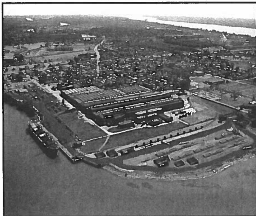
TERMINAL MARITIME SOREL-TRACY VUE GÉNÉRALE DES INSTALLATIONS EXISTANTES
